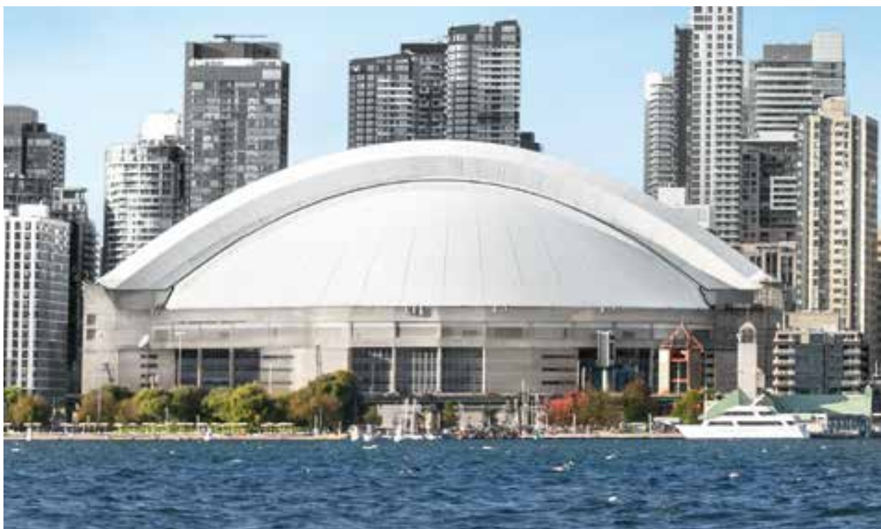
Das Rogers Centre in Toronto wurde 1989 mit dem weltweit ersten beweglichen Dach errichtet. 41'000 m 2 Sika Sarnafil Membranen wurden dafür verwendet. Bei der Sanierung 30 Jahre später wurde das gesamte Material wiederverwertet und das Dach erneut mit einem Sika Sarnafil System abgedichtet.
